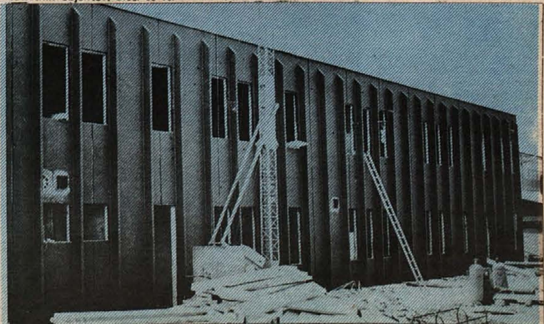
Nova upravna stavba Togrel v Drnovem
