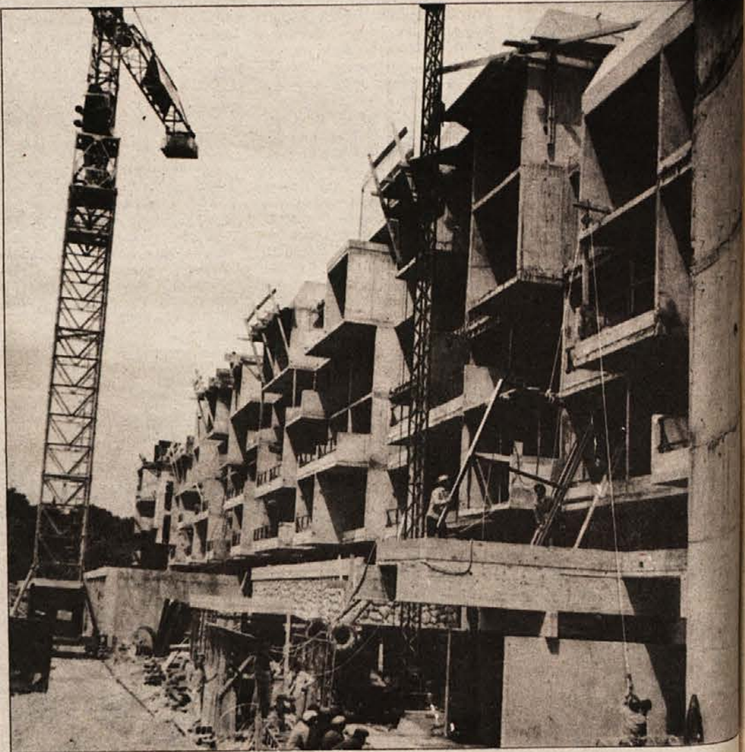
Danes gradbišče – jutri hotel
