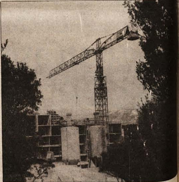
Lastna betonarna za potrebe gradbišča na Rabu
