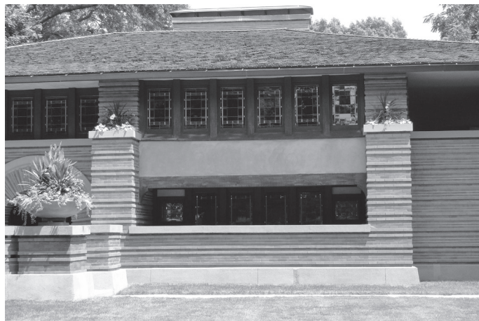
Slika 11: Hiša Heurtly, Oak Park, Illinois, 1902 – elementi prerijske hiše: romanska opeka poudarja horizontalne linije, niz povezanih oken z okraji v steklu, posoda (žara) ob vhodu, širok in nizek dimnik.
