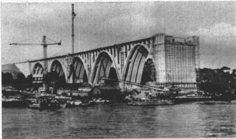
Auf dem Land ruht die Brücke auf fünf bzw. drei Bögen aus Eisenbeton
