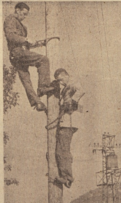
Elektro Gorica — montaža daljnovodov
