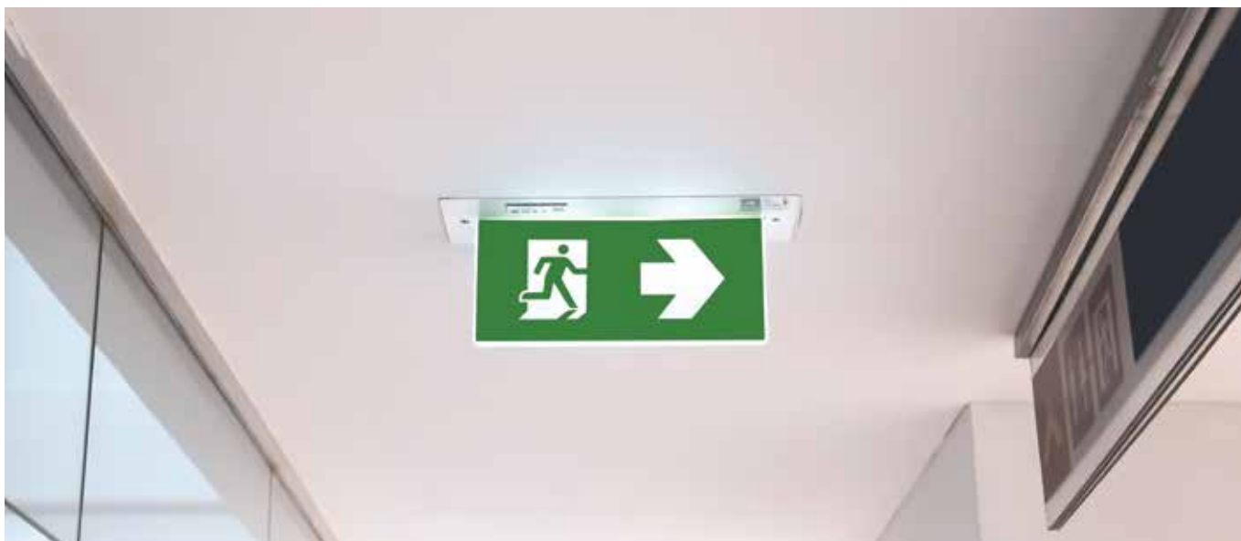
Slika 3: Med SAPZ še vedno sodi tudi varnostna razsvetljava, ki osvetljuje evakuacijske poti
