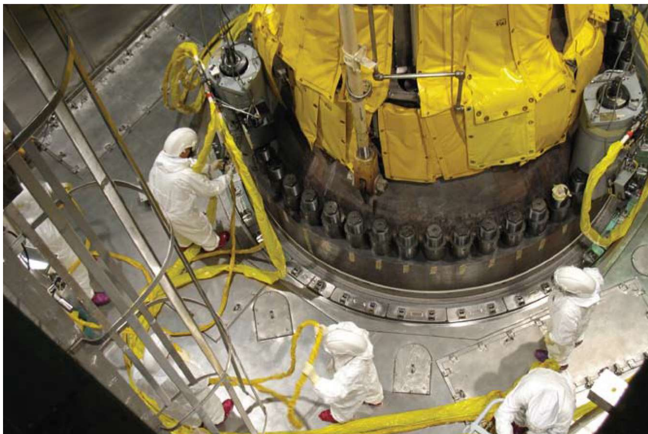
Remont v Nuklearni elektrarni Krško
