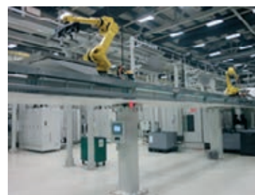
»» Uporaba portalne osi za robote za zalaganje strojev.
