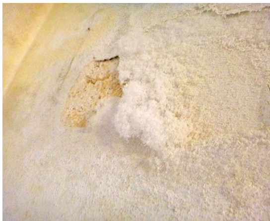
Slika 1: Nastanek solitra (vir: http://www.timopara.si/dejavnosti/sanacija-kapilarne-vlage/nastanek-in-posledice-kapilarne-vlage )
