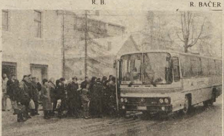
KONČNO PRAVA POSTAJA — V osnutku programa del iz novega samoprispjevka je tudi gradnja prepotrebne avtobusne postaje v Metliki, kajti sedanje zasilno, neurejeno pa tudi nevarno postajališče nikakor ne ustreza današnjim potrebam.
