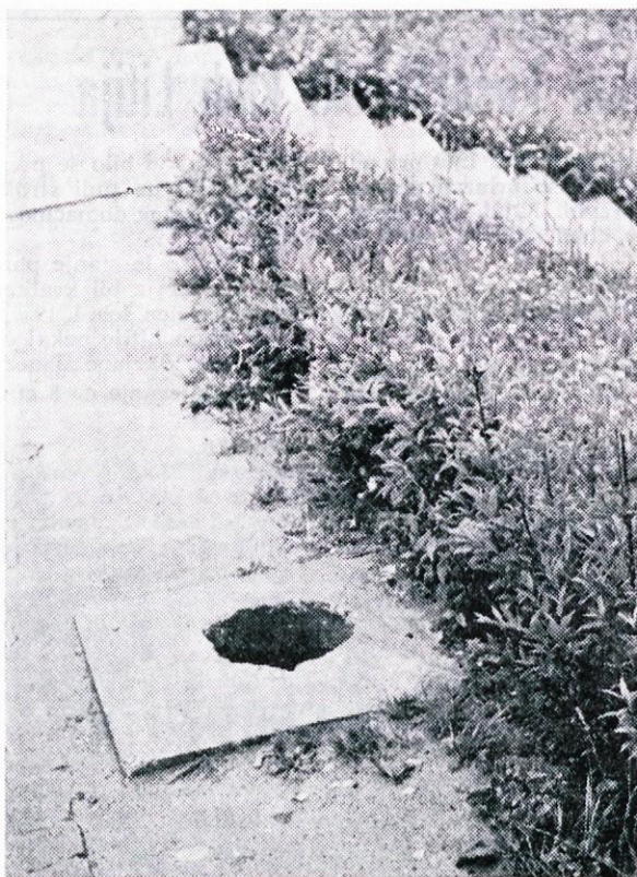
Ob pločniku poleg mosta in nadvoza so še vedno odkrite luknje, kamor sodijo drogovci za razsvetljava. Tudi za zlom noge so »zelo primerne«.
