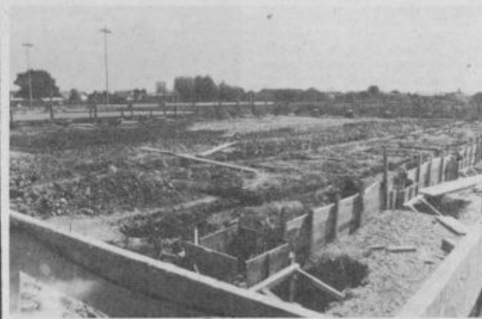
Pogled na začetke gradnje nove telovadnice
