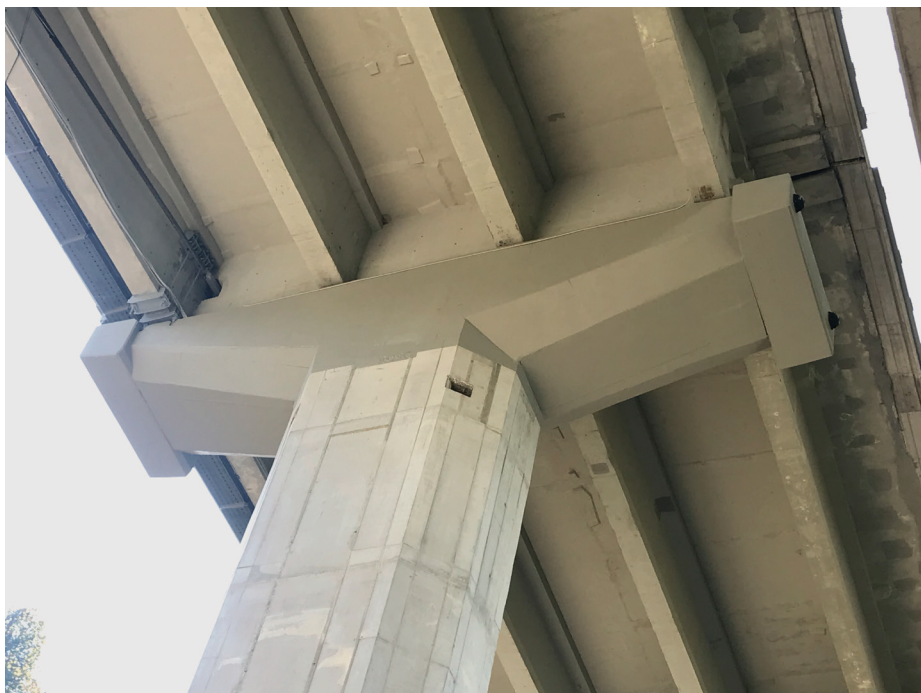
Slika 4 • Glava stebra po ojačitvi.
