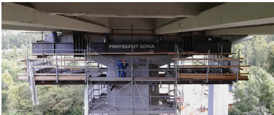
Slika 5 • Zamenjava ležišč z uporabo jeklenih jarmov (tehnologija in izvedba Freyssinet Adria SI, d. o. o.).
