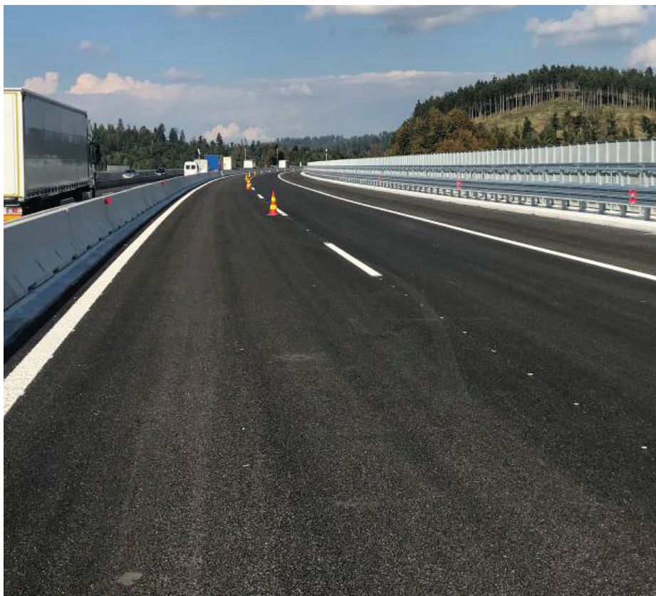
Slika 10 • AC na viadukih Ravbarkomanda po obnovi.
