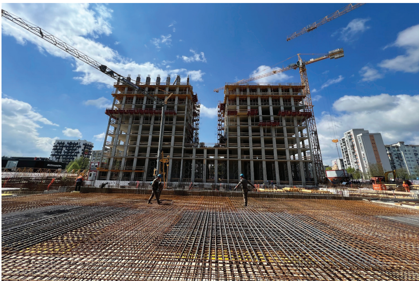
Slika 10. Gradnja trgovskega dela objekta, v ozadju gradnja stolpnic, april 2022.
