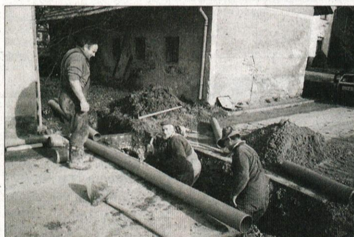
Ob gradnji kanalizacije so večkrat morali prekopati cesto in preusmeriti promet. Zastaja v prometu kljub temu ni bilo.
