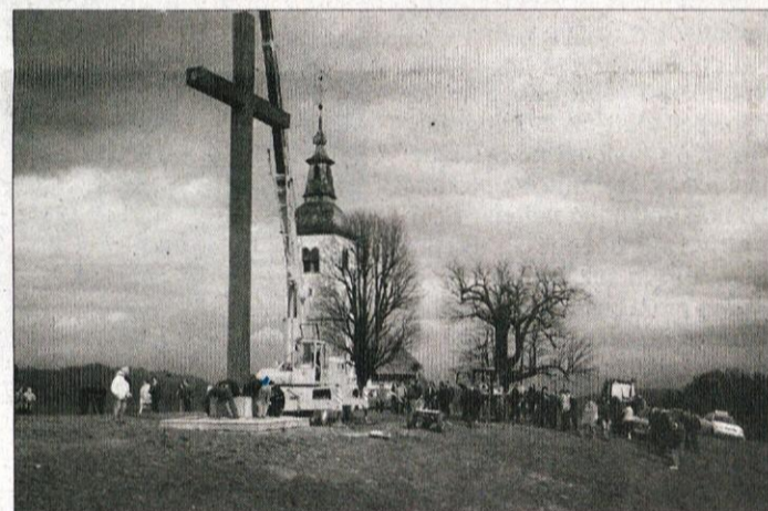
S pomočjo dvigala so postavili križ na betonski podstavek. Kljub strupenemu vetru je postavljanje opazovalo veliko gledalcev.
