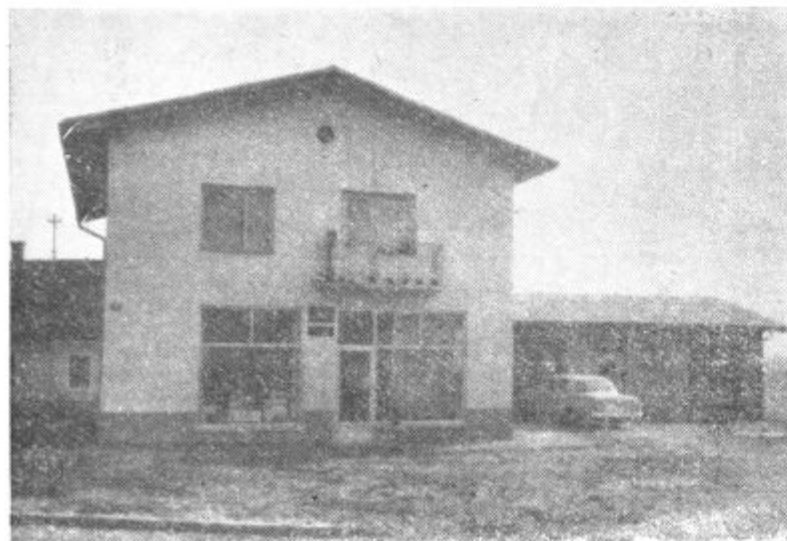
Zgradba Elektro Maribor, rajon Lenart na Radgonski cesti
