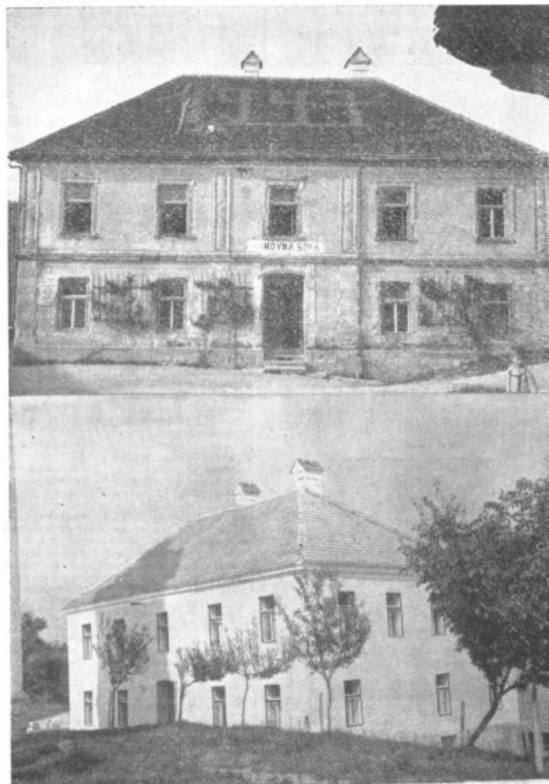
Lani so v Ščavnici obnovili tudi šolsko poslopje, ki je bilo zgrajeno pred 100 leti. Na sliki zgoraj: pred obnovo, spodaj isto poslopje po obnovi
