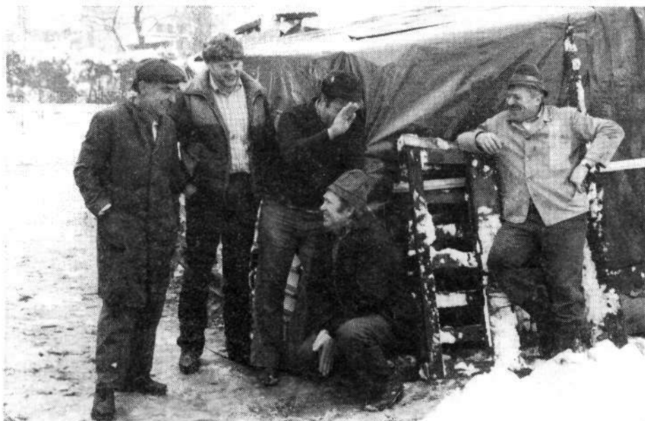
Vrli kamniški planinci so skrbno zaščitili gradbeni material. Skrajni desni je načelnik gradbenega odseka — Lado Golob, ki je šel kar 530-krat na prostovoljno delovno akcijo. Posnetek Breda Zajc
