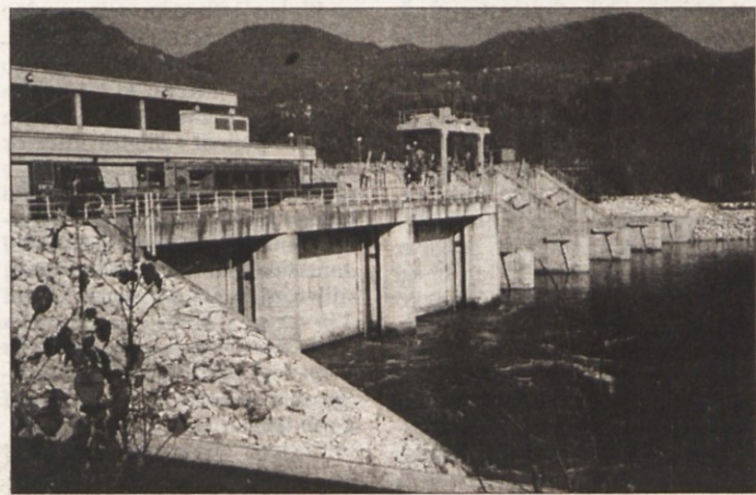
NAJ SE NE PONOVI VRHOVO. Posavci si nikakor ne želijo, da bi se gradnja načrtovanih novih elektrarn na Savi vlekla, kot se je gradnja na Vrhovem, še manj, da bi se nekje na sredini zaustavila. (Foto: B. D. G.)
