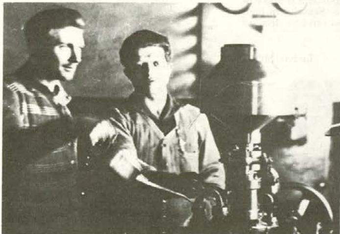
Električna centrala — notranjost. Na sliki: vzdrževalca električne centrale Jaš in Gumpot.
