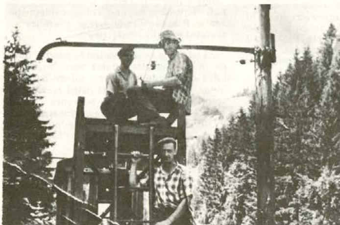
Da so lahko popravili okvare, so morali včasih splezati tudi na streho lokomotive. Na strehi lokomotive: Justin Tisnikar in Krenker; ob lokomotivi stoji Furjan.
