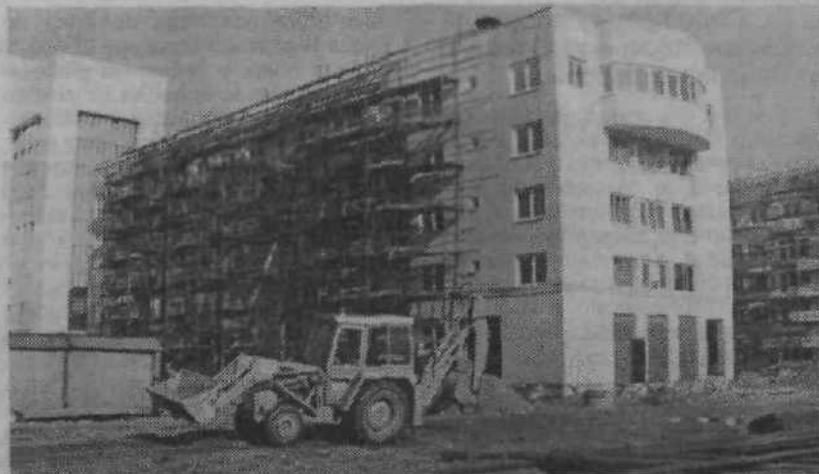
Na blokih pri Smeltu so graditelji SCT opravili že vsa zidarska dela. Ostajajo le še obrtniška dela znotraj objektov ter ureditev okolice, ki je bila vezana na gradnjo hišnih priključkov. Foto: A. G.
