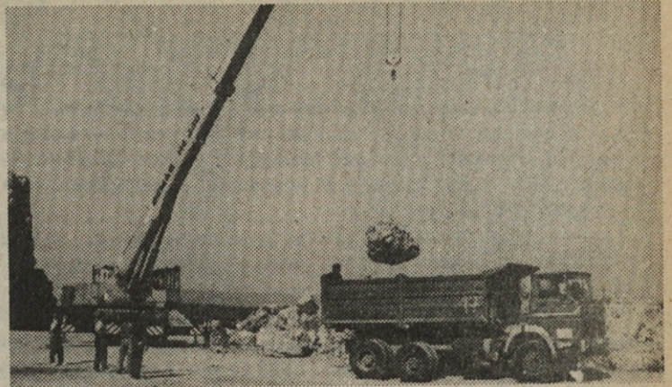
Skale iz Črnega kala vozijo tudi za valobran marine v Ičićih pri Opatiji.
