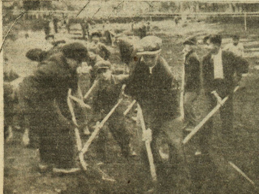
Rudarski in kovinarski vajenci kopljejo temelje za internat
