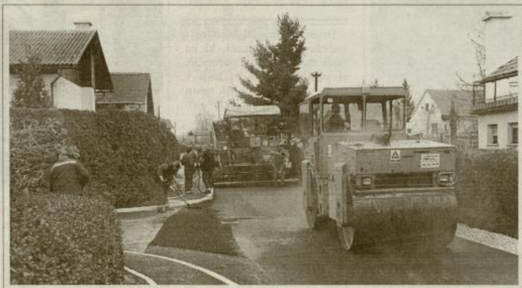
Zaključna dela na Bregu.
