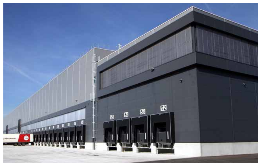
Logistični objekt ima kat 100 nakladalnih ramp, na strehi pa ogromno sončno elektrarno.
