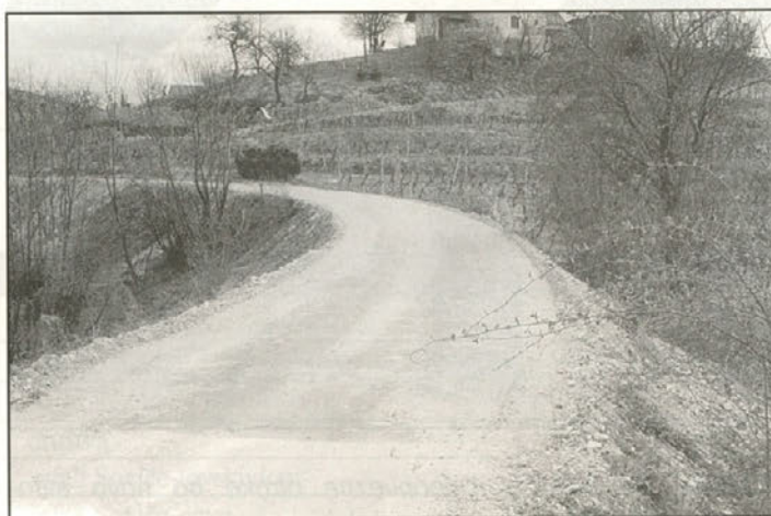
Cesta med Majskim Vrhom in Ljubstavo bo kmalu asfaltirana
