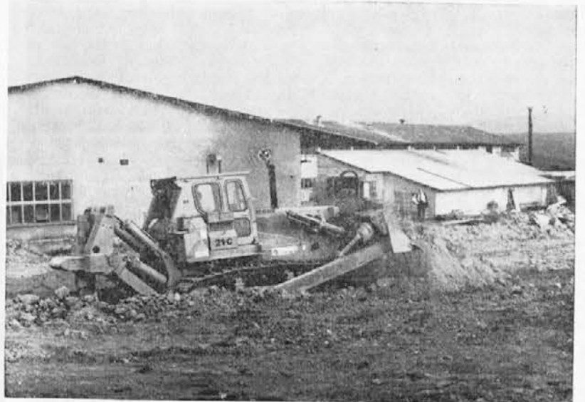
V tozd Sudest so pričeli z delom na gradnji novih prostorov za povečanje proizvodnje in skladiščnih kapacitet.
