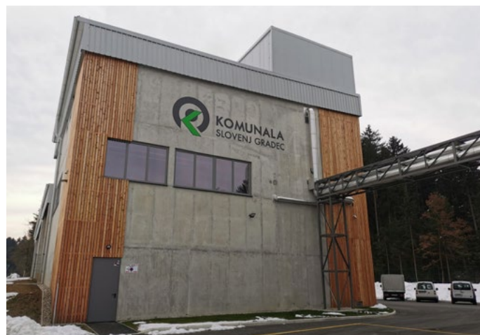
Daljinsko ogrevanje Slovenj Gradec (Toplarna Štibuh) Foto: Komunala Slovenj Gradec
