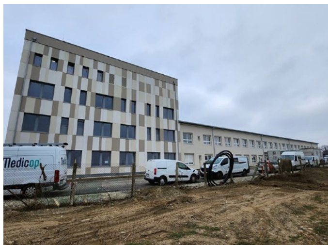
Foto: arhiv Splošne bolnišnice Murska Sobota
