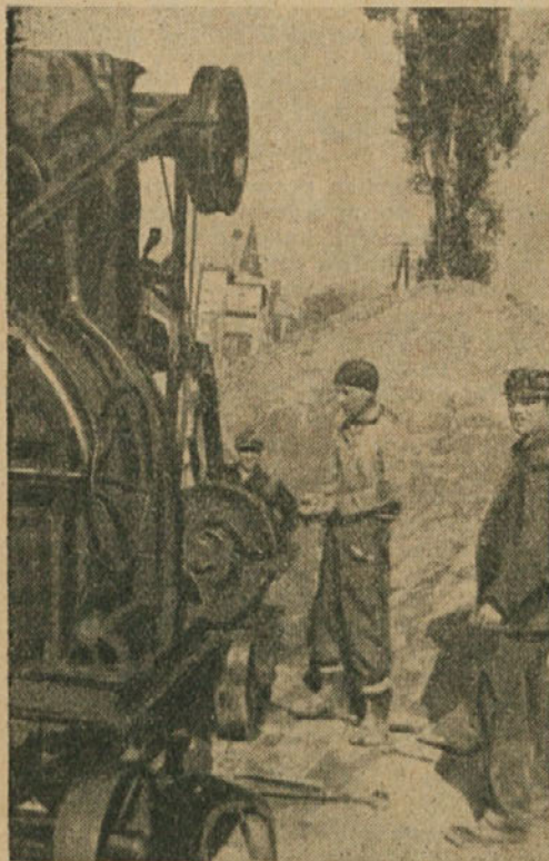
Betonski mešalec je skrbno pripravljen in podmazan; čaka ga obilo dela pri betoniranju mostu čez Savinjo
