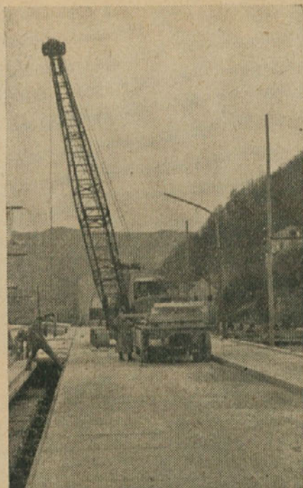
Montaža betonskih plošč
