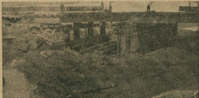
Montaža jeklenih I nosilcev — »Pajnerjev«
