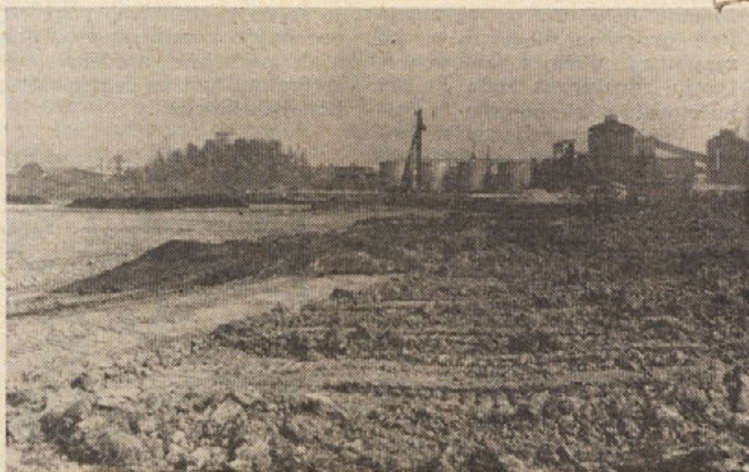
Tako je izgledalo zemljišče, kjer danes stoji skelet hale novega obrata titanovega dioksida
