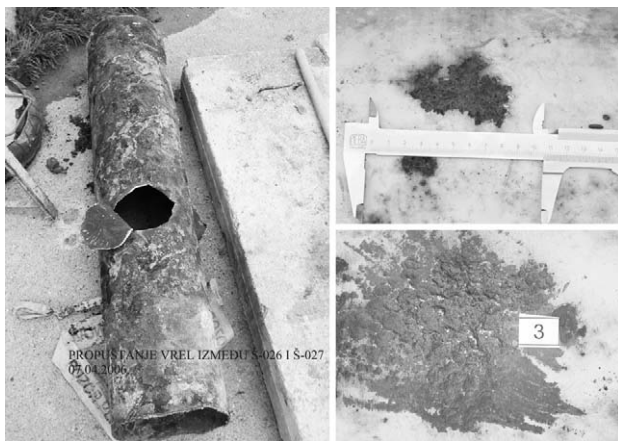
Figure 2: Determining the geometry of hot-water-pipe defects Slika 2: Določitev geometrije poškodb vročevodne cevi
