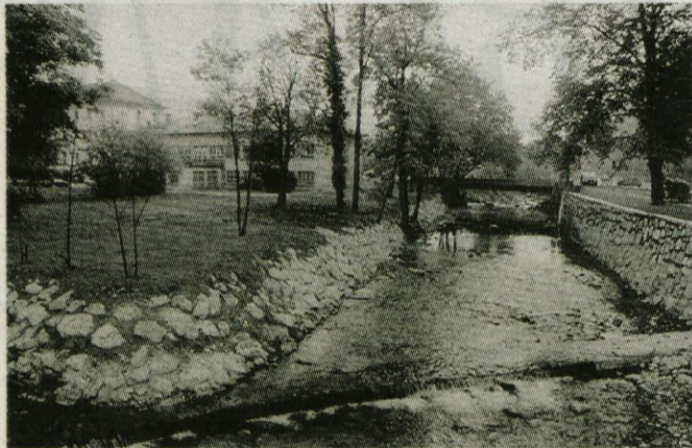
Te dni potekajo zaključna dela pri urejanju brežin Nevljice in Kamniške Bistrice ob sotočju pred Maistrovim mestom v Kamniku, katerega podoba je tako še bolj prišla do izraza.
