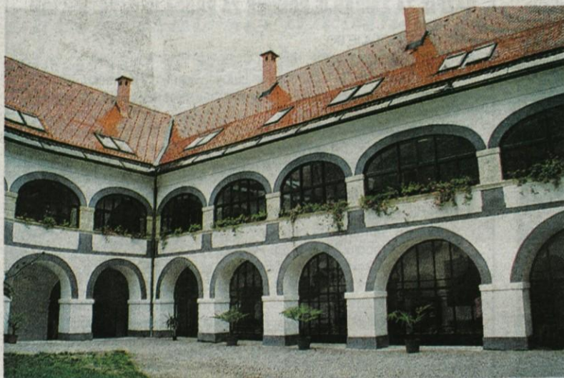
Samostan v Mekinjah, ki je potreben temeljite prenove, je dočkal prenovljena krila atrija.
