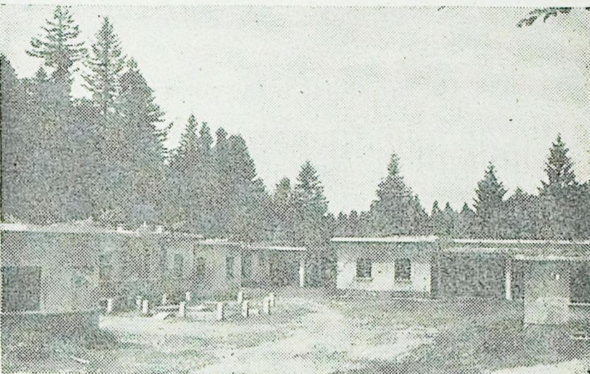
Razpadajoče zgradbe na Mašunu
