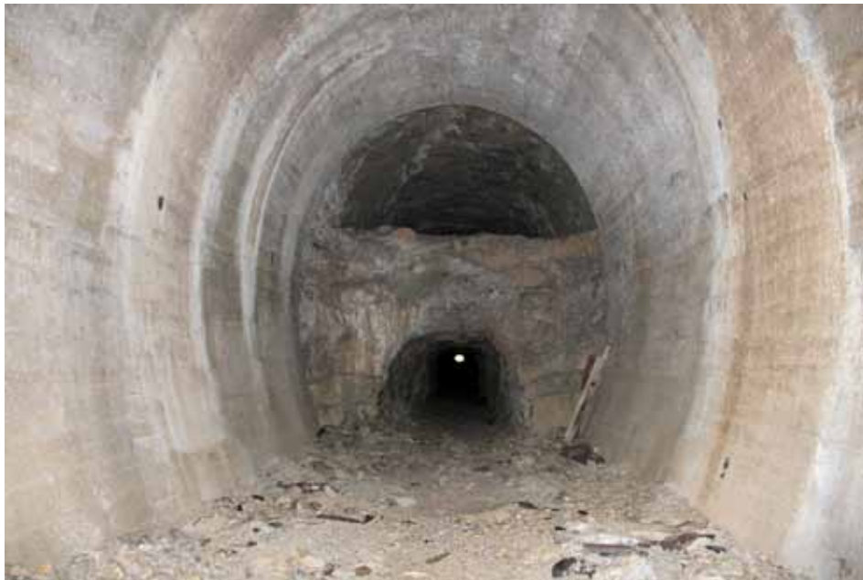
Gradnja predora pri Godoviču.
