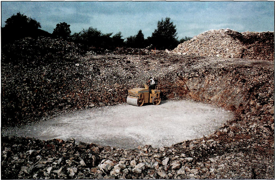
Fig. 2: Filling up a doline Sl. 2: Zasipanje vrtače
