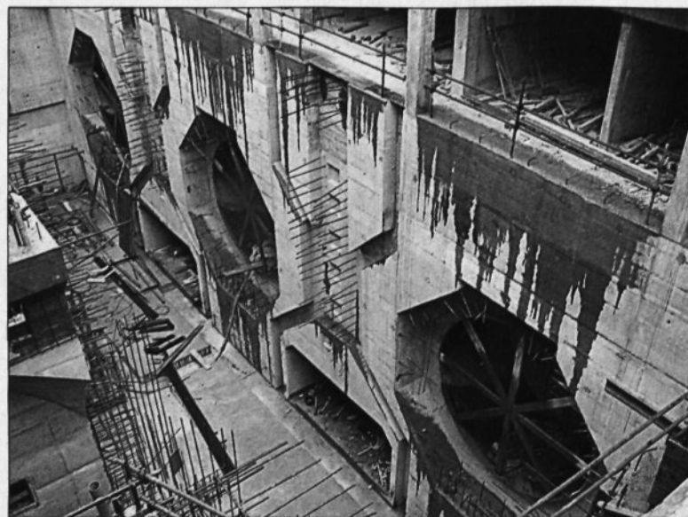
Med najbolj osupljivimi prizori je pogled v notranost strojnične zgradbe.
