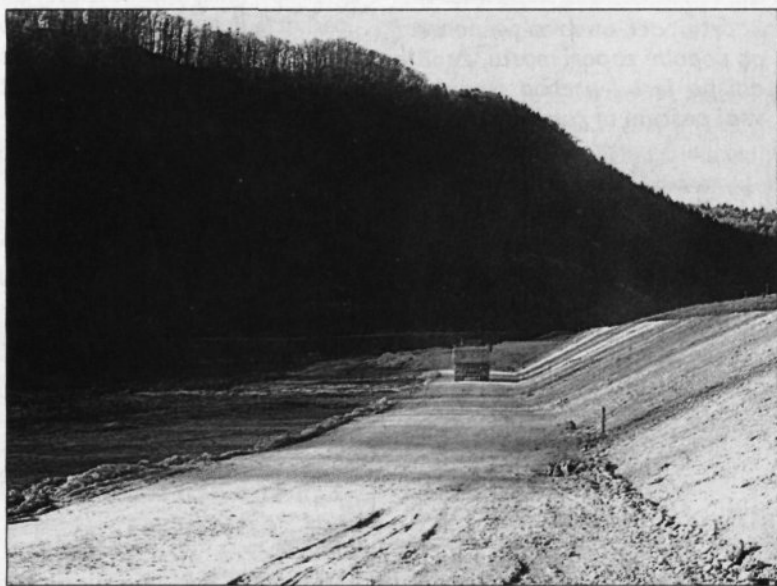
Infra sodeluje tudi pri gradnji akumulacijskega bazena.
