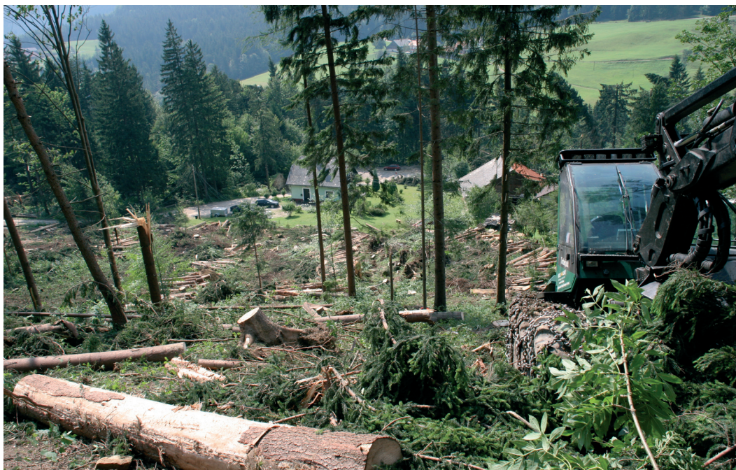
Slika 3: Sanacija vetroloma na Črnicu (foto Jurij Beguš)
