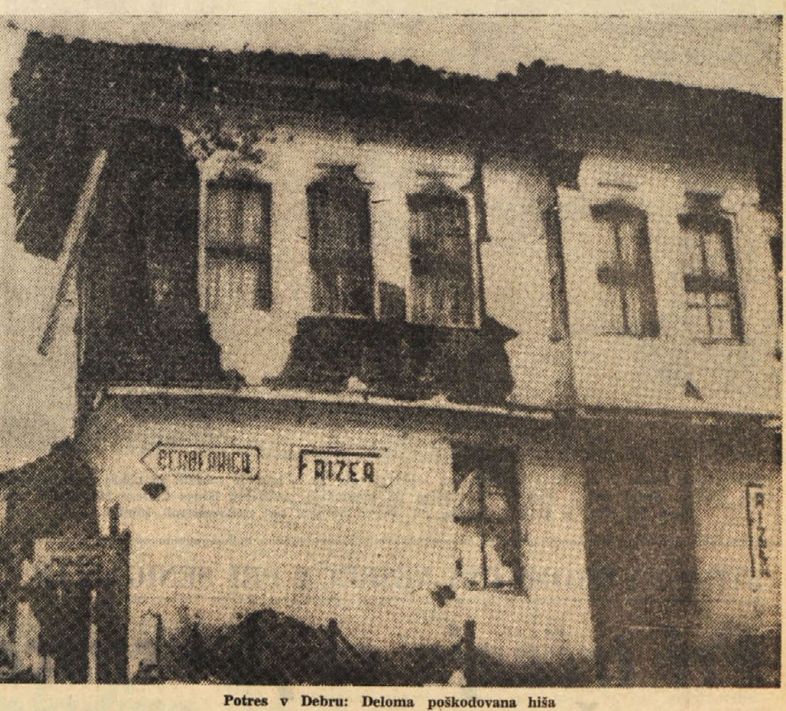
Potres v Debru: Deloma poškodovana hiša
