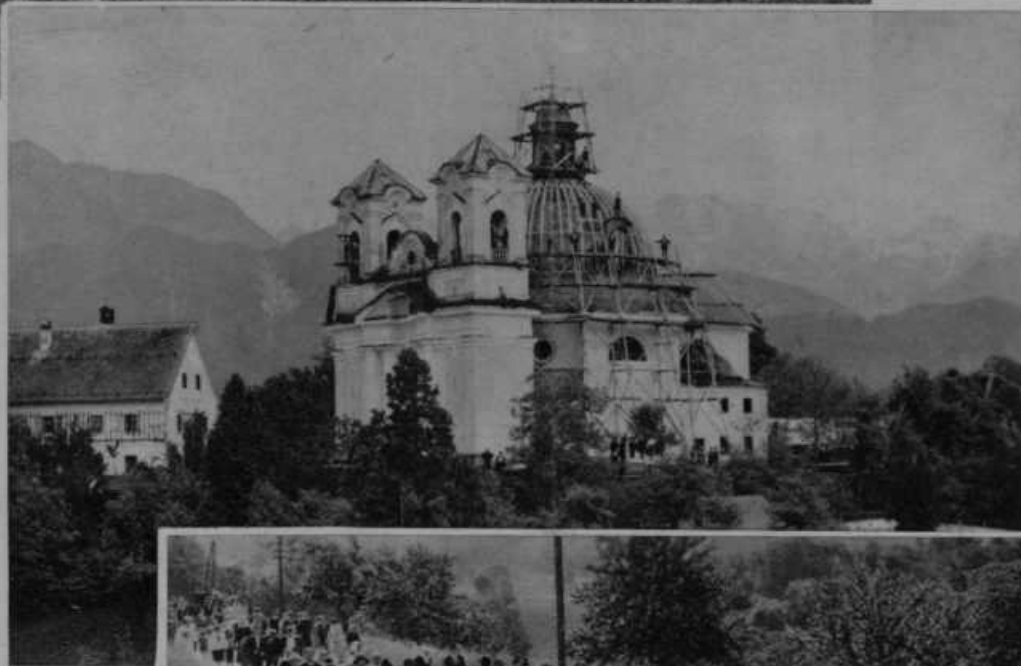
Tunjiška farna cerkev (pri Kamniku) je deloma pogorela. Vneti župljani pa so se takoj lotili dela, da cerkvi vrnejo prejšnjo lepoto. — Slika nam kaže graditev ogrodja za kupolo. Pozneje pride ta na vrsto tudi oba lepa zvonika.
