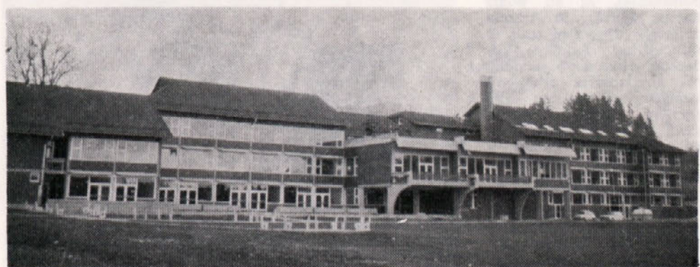
V novembru so na več gradbiščih pospešeno izvajali zaključna dela, da potem objekte predamo namenu za Dan republike. Tako je bilo tudi v Grmovju z Domom oskrbovancev
