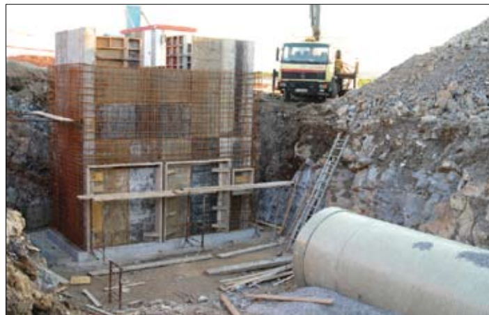
Objekt grablje v pripravi na betoniranje ter delček zadrževalnega polja
