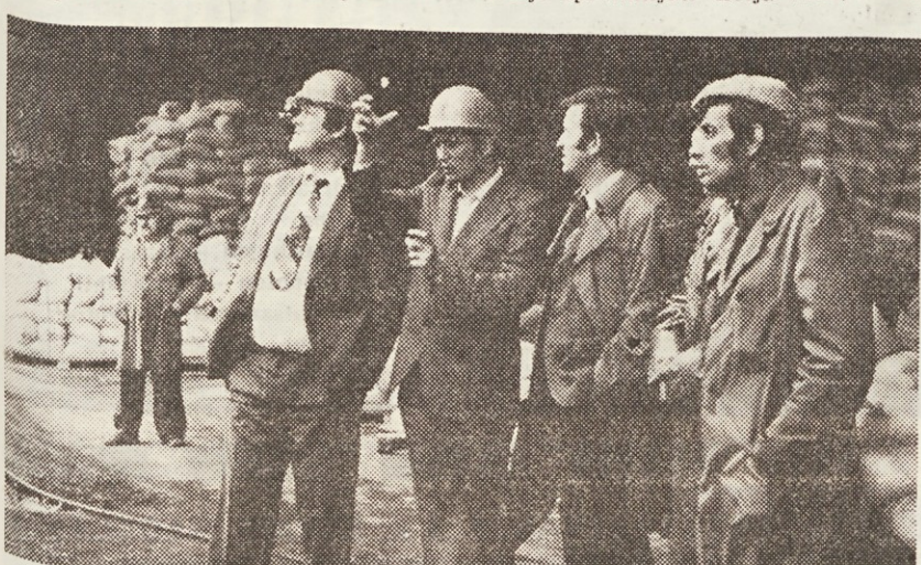
Ob zahtevnem delu na gradbišču je včasih potreben tudi posvet naših strokovnjakov (ing. Krunič, ing. Primorac in ing. Vrečko)
