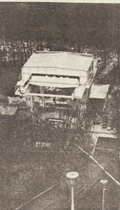
Beton je potrebno z vrha hriba spraviti v gradbeno jamo ob strojnici, kjer bo delal 4. agregat za HE Moste
