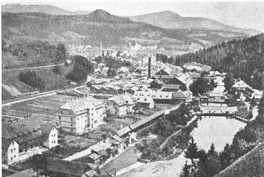
Prevalje v času, ko je tamkašnja železarna najbolj uspevala (1885 do 1890). V ospredju valjarški itd. obrati, v ozadju na levi visoke peči. Klišje je napravljen po barvni sliki, zato podoba ni več tako izrazita kakor na originalu. Takrat so Korošci še znali slikati.
