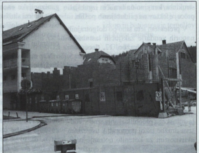
Delavci Gradbeništva Ravne v Prevaljah gradijo nov stanovanjski blok
