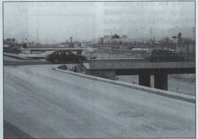
Nadvoz na severni obvozni cesti v Ljubljani
