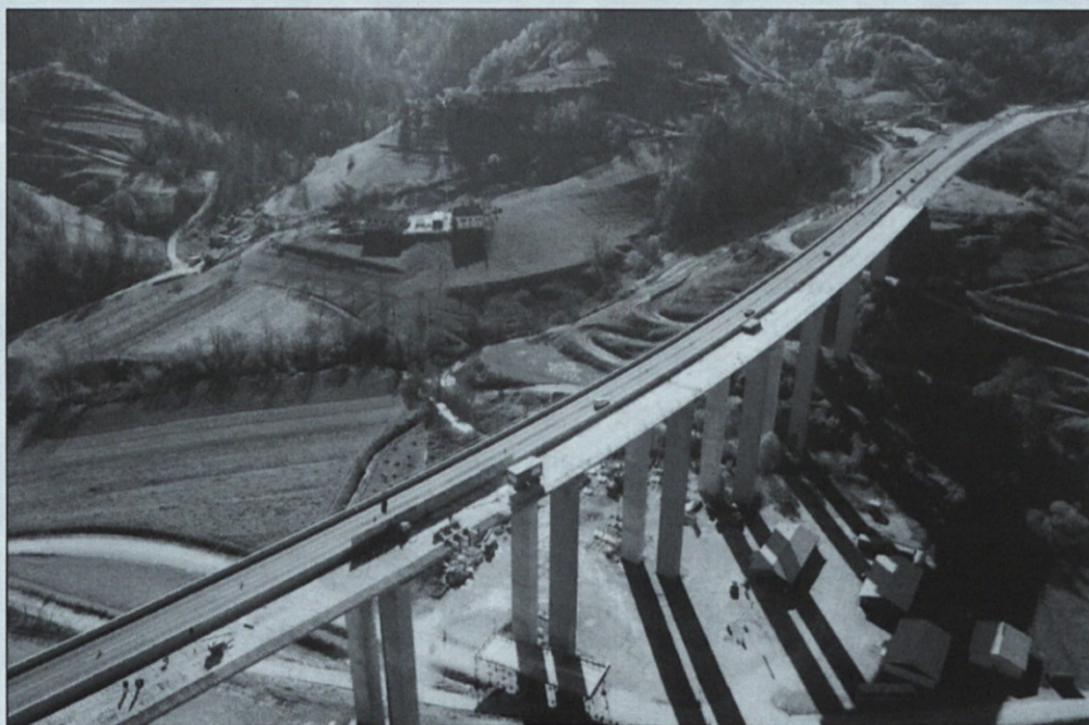
Viadukt v Škedenjski dolini na avtocesti Hoče-Arja vas
