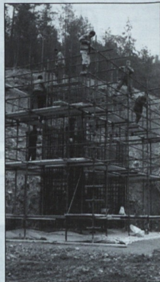
Priprava armature za stebre viadukta Bizovik.
