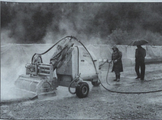
Rušenje betona z vodnim curkom
