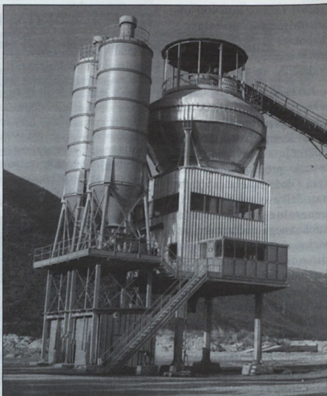
Stolpna betonarna Gradis Tosin
