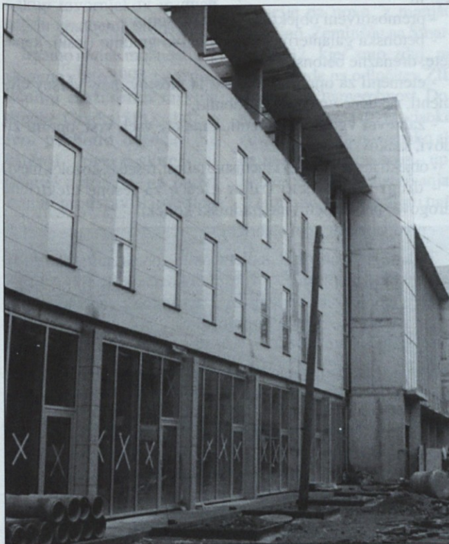
Delavci podjetja Gradis Nova te dni končujejo poslopje Andreanuma - teološke fakultete v Mariboru, na Veluščkovi pa gradijo stanovanjsko poslopje.
