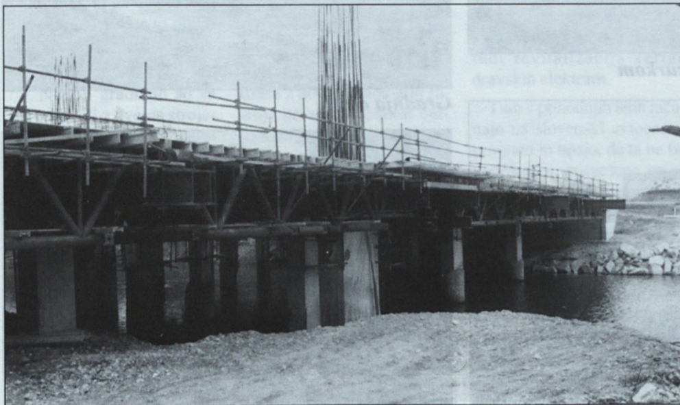
Most za avtocesto čez Ljubljanico bo do avgusta, ko bodo napeli jeklene kable, podprt z začasnimi nosilci.
