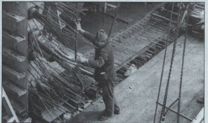
Prednapenjanje zgornje konstrukcije premostitvenega objekta
