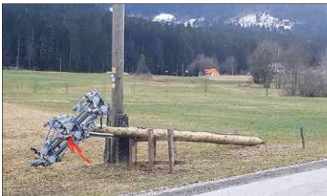
Zaradi vzdrževalnih del je bila na več lokacijah v Zgornji Savinjski dolini občasno prekinjena dobava električne energije.
