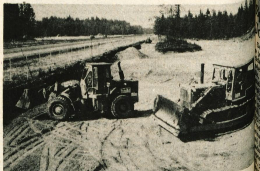
Cestarji so ob novi cesti pri Voklem začeli urejati zemljišče za novo bencinsko črpalko, ki bo skupaj z gostinskim delom zgrajena do poletne turistične sezone. Foto: F. Perdan
