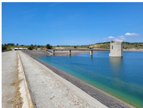
Krona in vodna stran pregrade Vallon Dol ter odvzemni stolp. Odvzem vode je možen na štirih nivojih.
