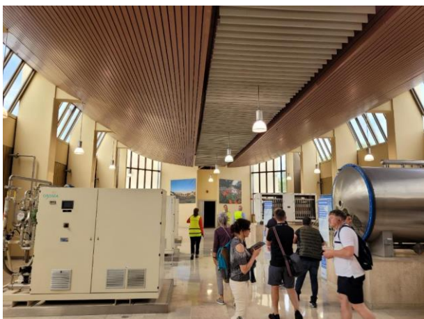
Vodarna Sainte-Marthe, glavna dvorana objekta za ozonacijo. Na levi so aktivni ozonatorji, na desni pa razstavljeni muzejski modeli.
