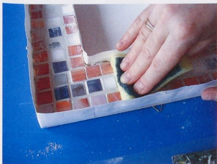
Slika 9. Ostranjevanje odvečne fugirne mase z vlažno gobico
