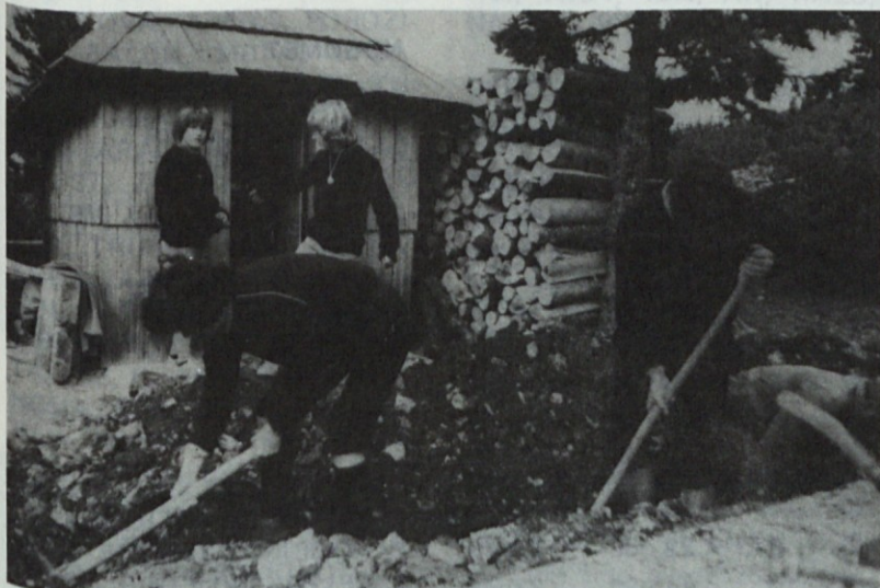
Kopanje odvodnega jaška pred kočico
