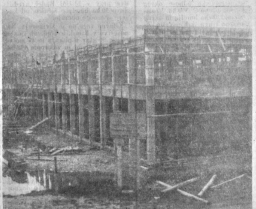
Sele pred dobrih dvema mesecema so začeli z delom, sedaj pa manjka samo še nekaj del in nova proizvodna hala tovarne gospodinske opreme »Gorenje« v Velenju bo z nadaljnjo gradnjo pričela dobivati svoje končne oblike. V kolikor bo vreme naklonjeno graditeljem, bo kolektiv »Gorenja«, ki se vtesnuje v prostorih starega jaška, lahko že v prvih mesecih drugega leta pričel z montažo strojnih kapacitet. — Nova tovarna bo po smotrnem izkoriščenju prostorov in čim bolj izpolnjenem tehnološkem procesu postala ena najmočnejših delovnih organizacij v komuni. Prehod na 6 do 7 milijard bruto produkta v treh letih nikakor ni nobena utvara za slehernega, ki pozna, kakšne skoke je ta kolektiv ustvaril v zadnjih dveh letih.
