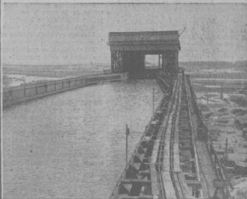
Levo zgoraj: V Brightonu na Angleškem so se že pričele poletne zabave — Spodaj: V plovnem kanalu med Berlinom in Vzhodnim morjem so zgradili velikansko dvigalno napravo, koje glavni del je 88 m dolgo, 18 m široko in 2.5 m globoko korito, ki se z ladjo vred lahko dviga in spušča 36 m visoko.
