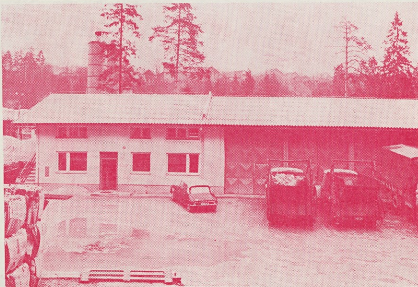
PE KRANJ s skladiščnimi prostori in prostori strokovnih služb poslovne.
